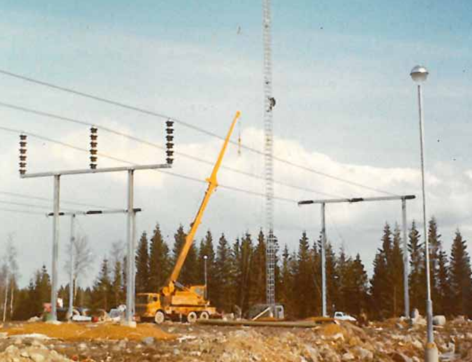
Tuovilan sähköaseman ukkostelineen pystytys 1971. (Joensuu)
