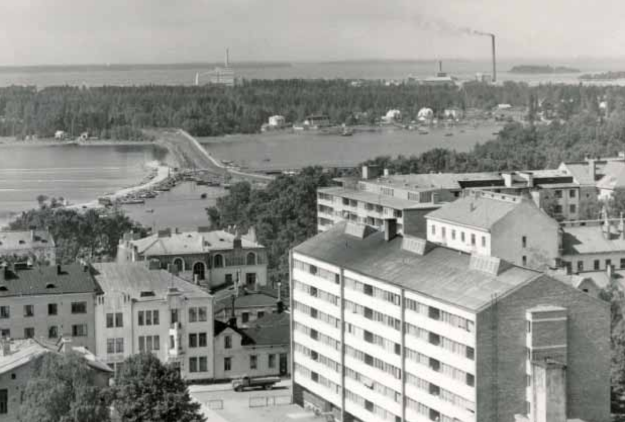
Vaasan keskusta. Kuva on otettu vuosien 1958-60 välisenä aikana. EPV:n voimalaitos on rakennettu Vaskiluotoon ja merenrannan pengerrys on aloitettu. (PM)
