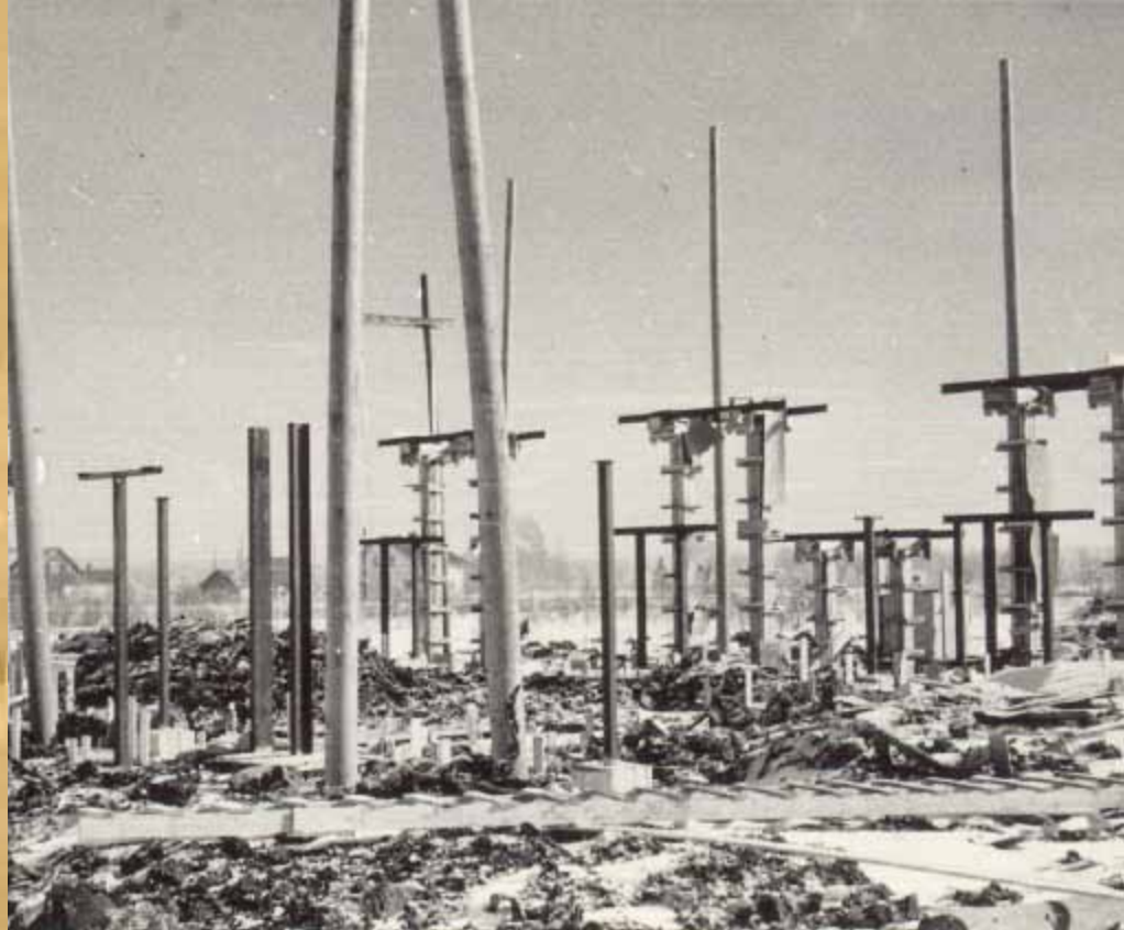
Lapuan Sähkö Oy:n kytkinlaitos keväällä 1955. (EPV)
