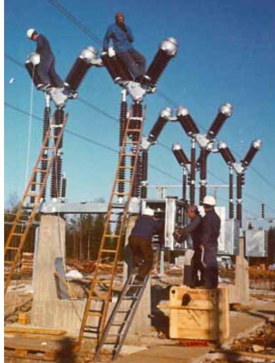
Tuovilan sähköasemalla 220 kV:n vähäöljykatkaisijan asennus 1971. (Joensuu)
