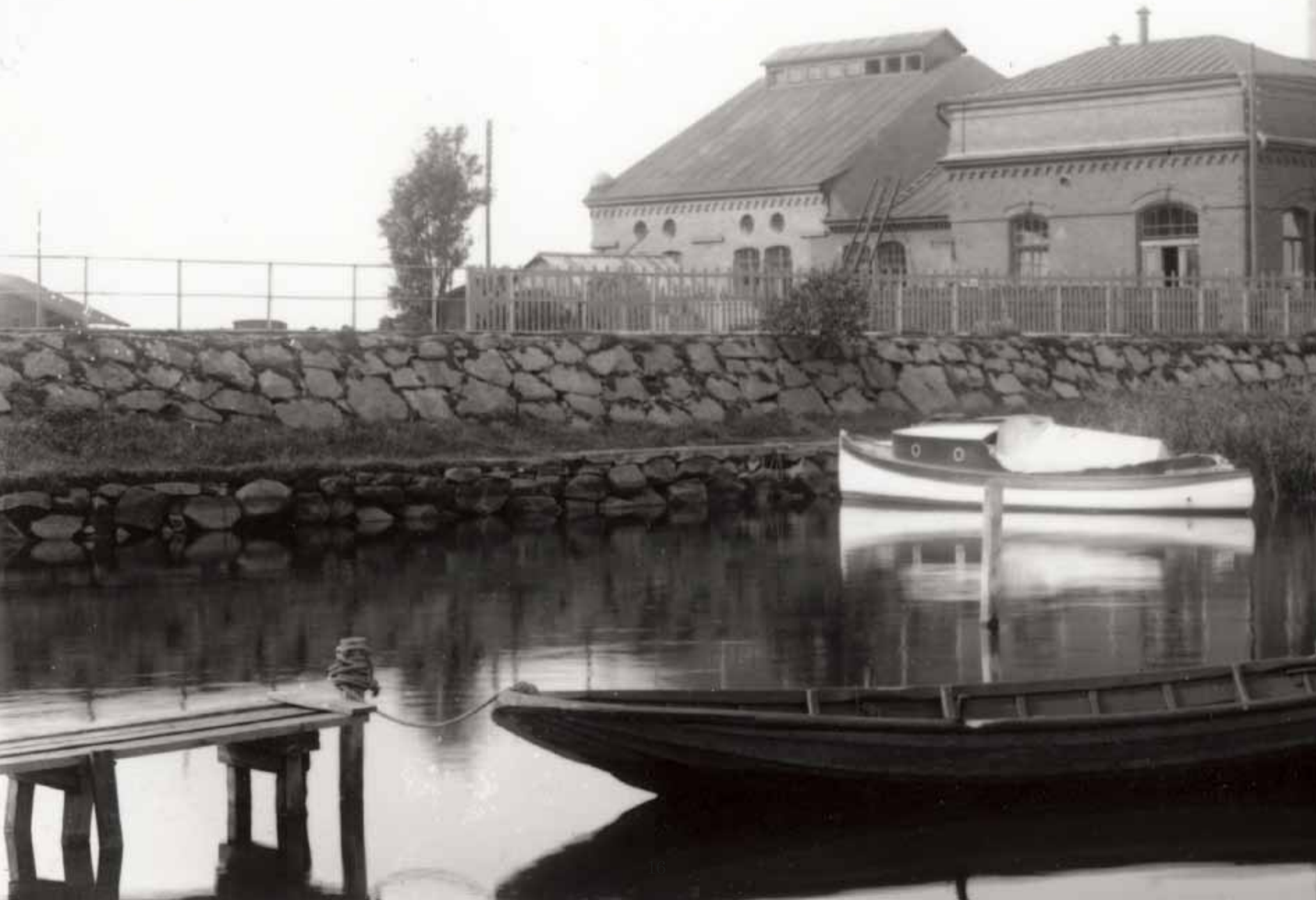
Ensimmäinen Vaasan Sähkön voimalaitos Palosaaren sillan luona. Kuva on vuodelta 1910. Taustalla valtava pino biopolttoainetta. (PM)
